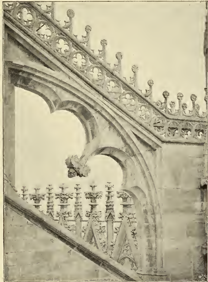
Abb. 12. Strebebogen (Detail) des Mailänder Domes.
